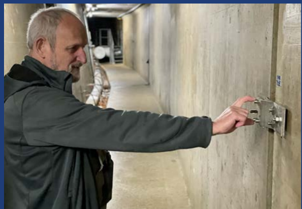
Anlagen-Fachkraft Lothar Brosowski bei einem regelmäßigen Check der Staumauer.
